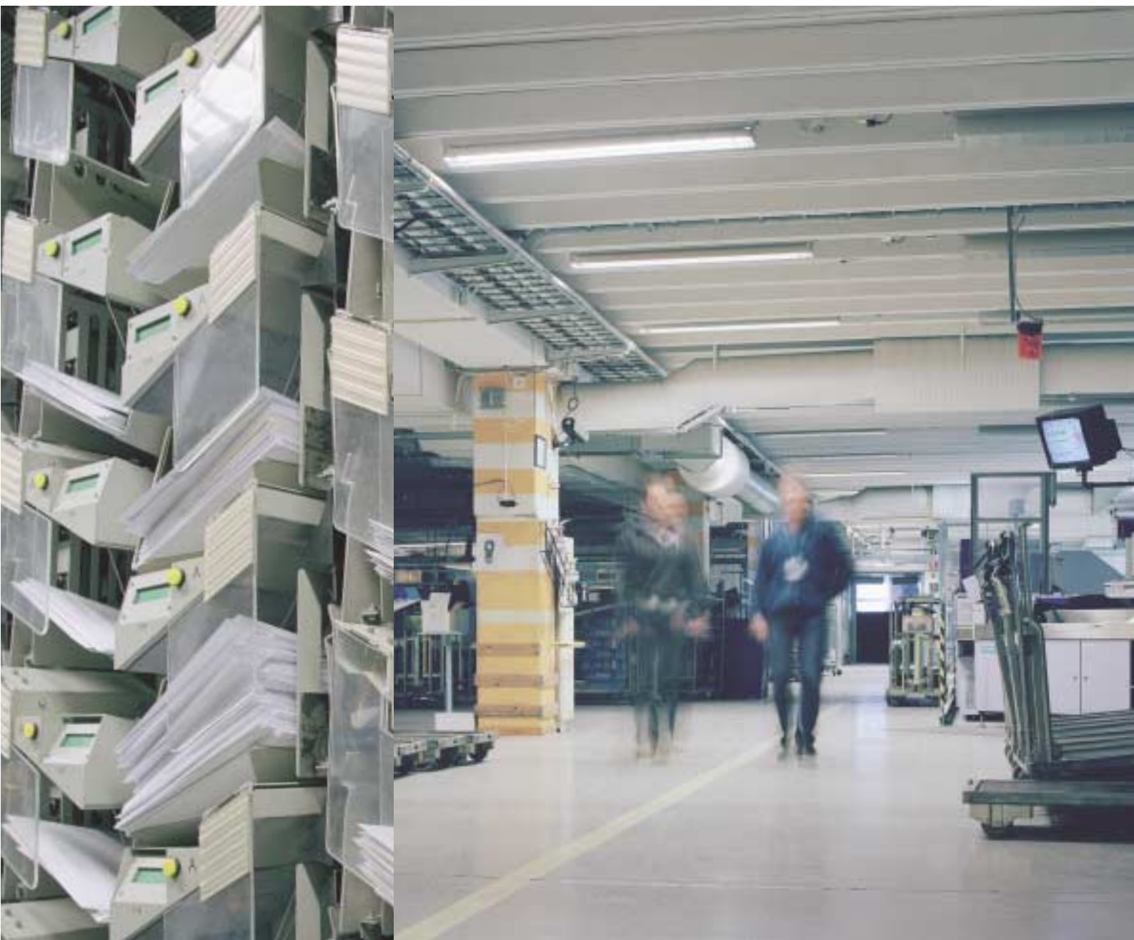
ANPASSAD BELYSNING. Den nya belysningen anpassades placeringsmässigt efter behovet av ljus i gångar och övriga utrymmen.
