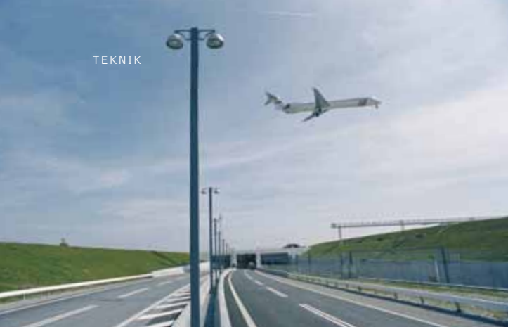
VÄL ANPASSAD belysningsanläggning, Öresundstunneln.
