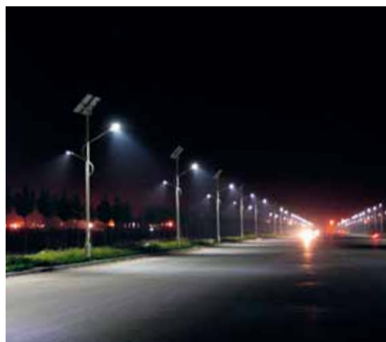
BLÄNDNING OCH DÅLIG LJUSFÖRDELNING från LED-armaturer.
