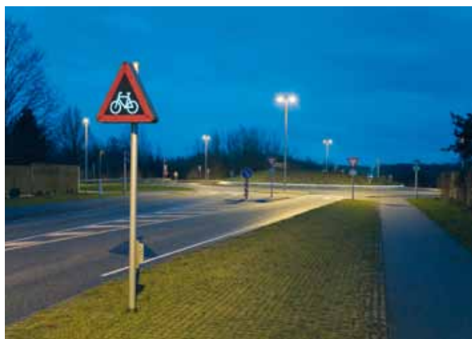
EN VANLIGT FÖREKOMMANDE VÄGBELYSNINGSANLÄGGNING och markering av rondell med fiberoptisk belysning, Hörsholm Danmark.
